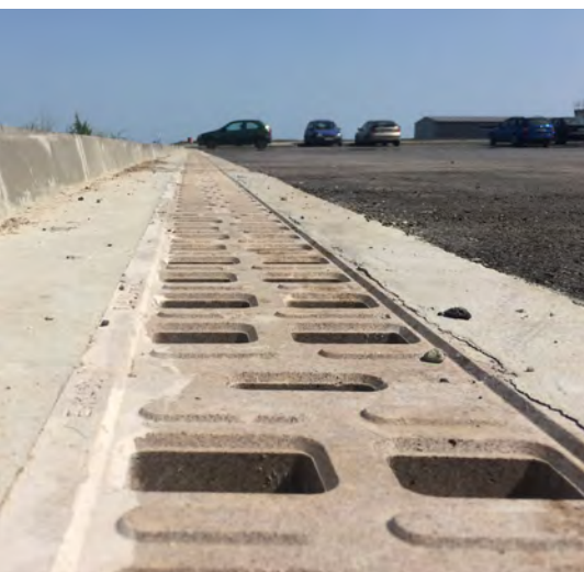
ACO Monoblock RD - монолитна отводнителна система
