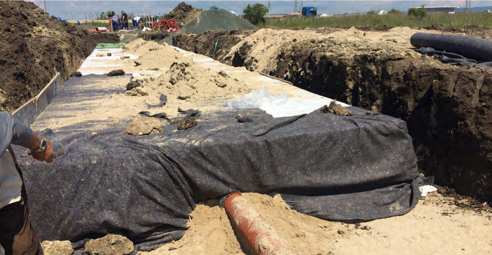
ACO Stormbrixx - система за съхранение и инфилтрация на дъждовни води
