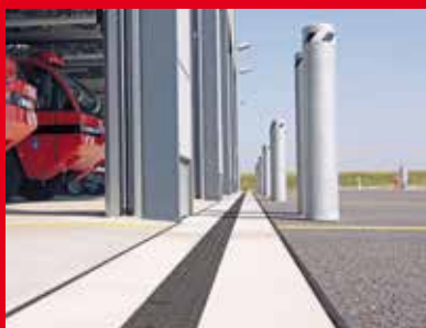
Усилена отводнителна система
