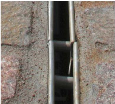
Свързване на слотови решетки без слот конектор
