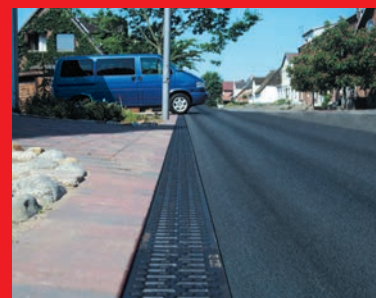
Монолитна отводнителна система
