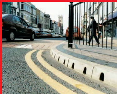
Бордюри с интегрирана отводнителна система
